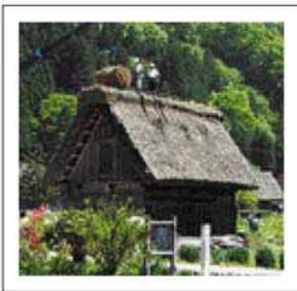
棟茅作業風景
